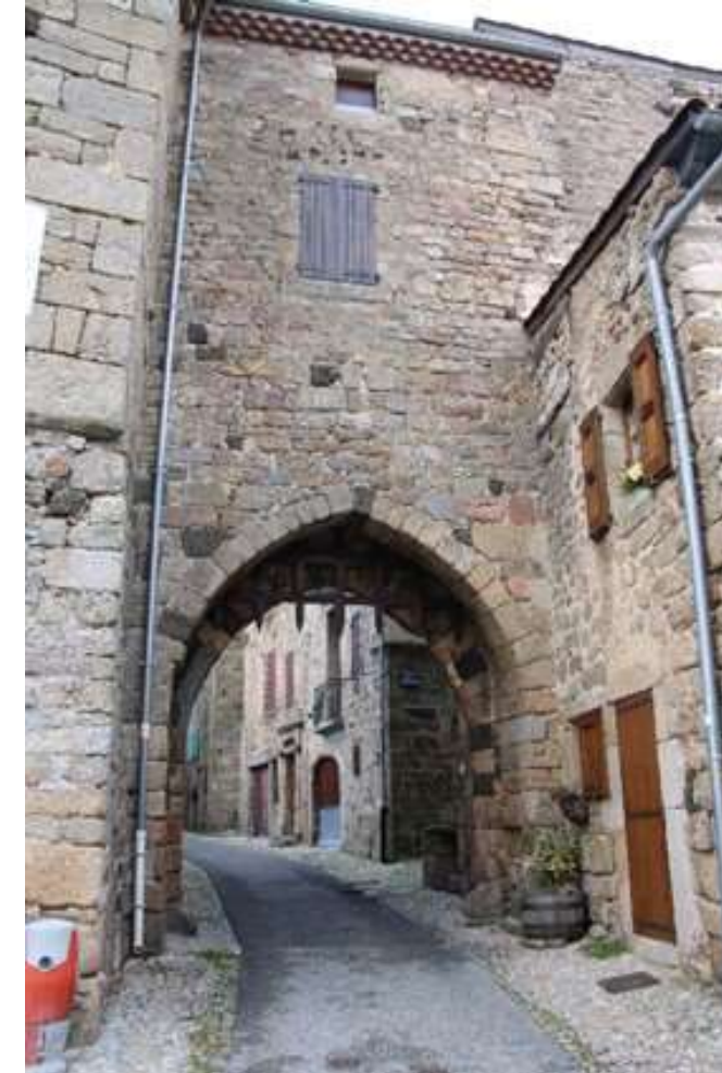
Figure 161 : La porte du Besset - T&P
