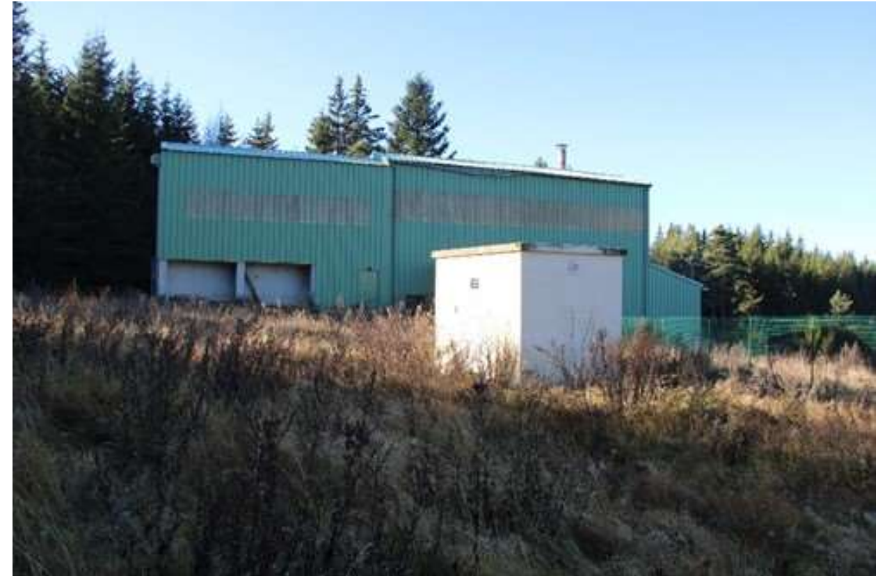
Figure 193 : Le bâtiment existant - T&P
