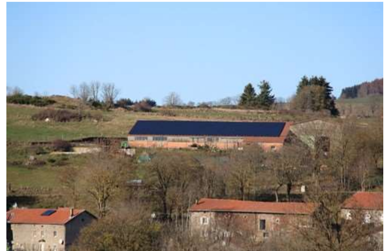
Figure 201 : Les toitures photovoltaïques des bâtiments - T&P
