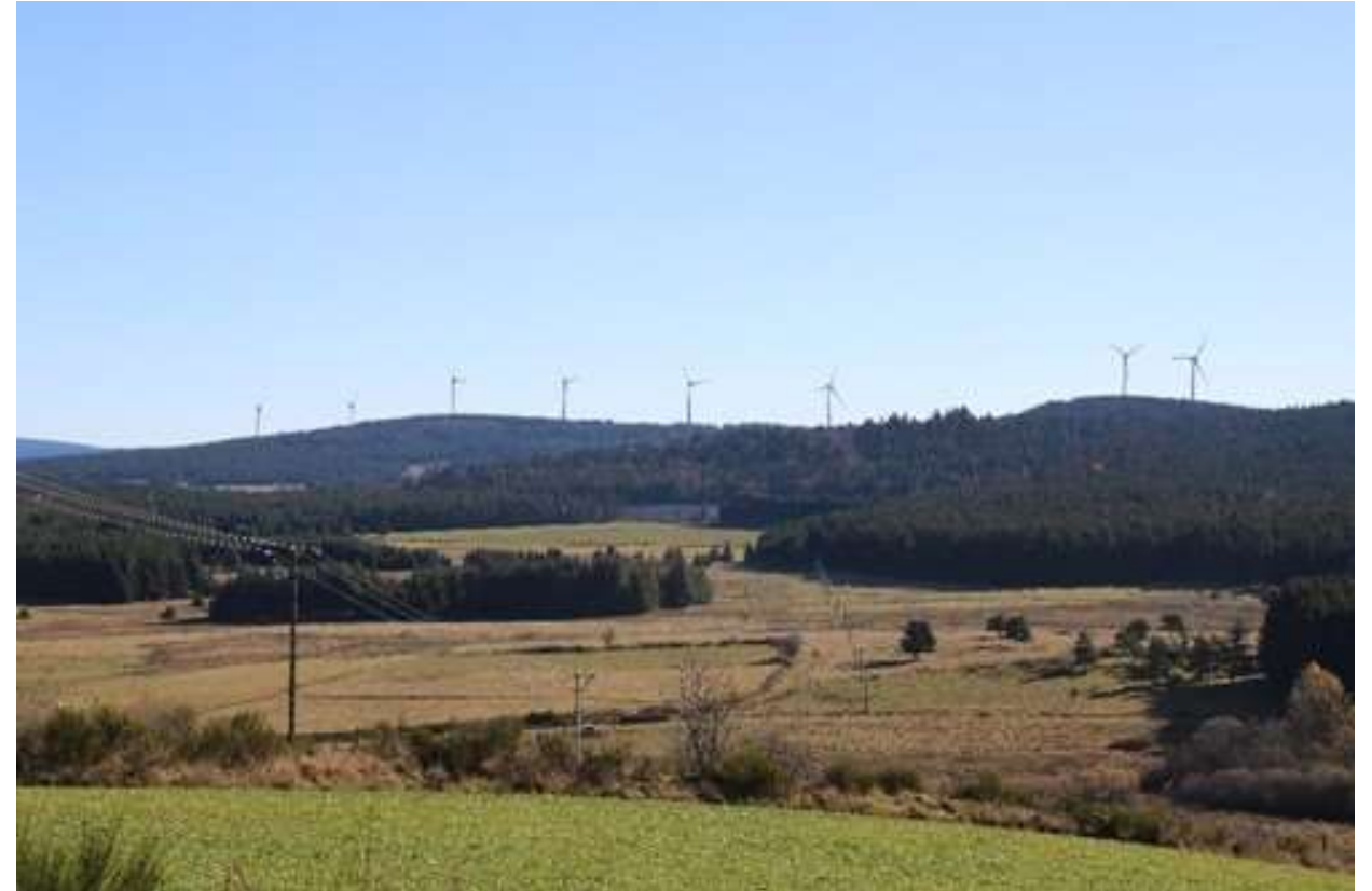
Figure 182 : Le parc éolien de la Montagne Ardéchoise - T&P
